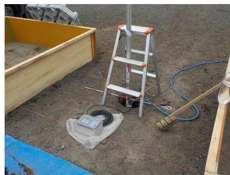
写真 2-11 現地浸透試験状況
