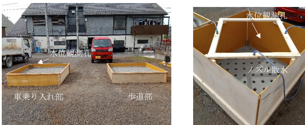
写真 2-10 散水試験施設
