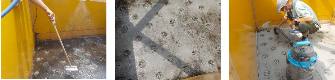
写真 2-15 10 年分 SS 負荷状況(ケース I)と砂利洗浄のための回収
