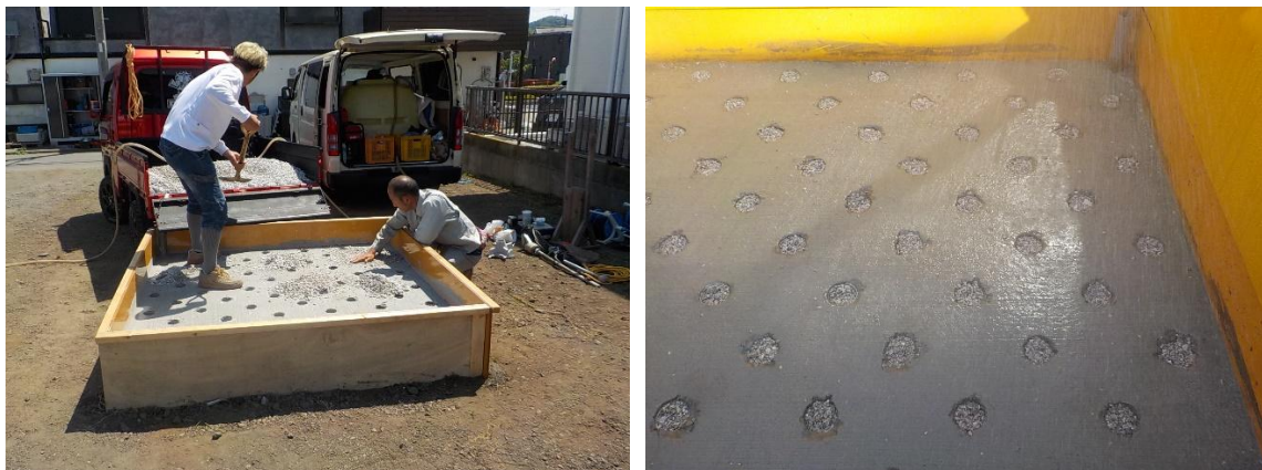
写真 2-13 小粒砂利の充填状況
