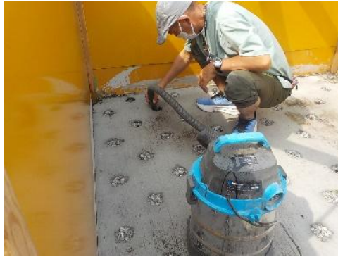
写真 2-19 バキュームクリーナーによるドット孔充填材の吸引状況
